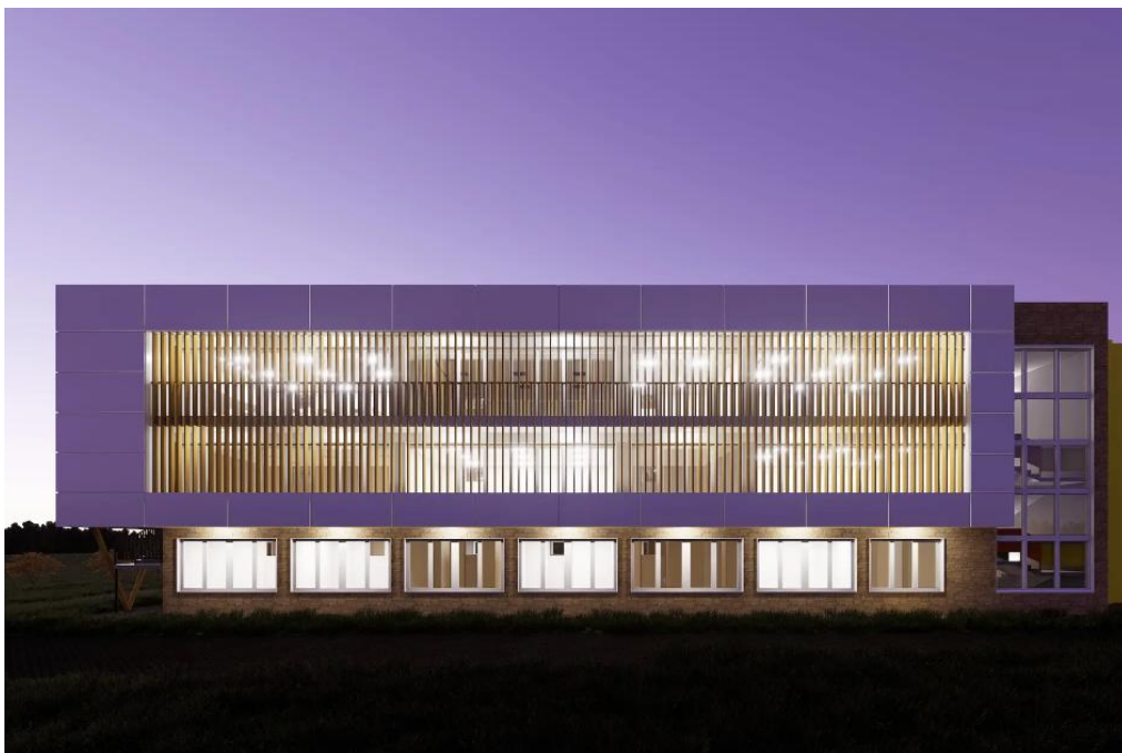
Slika 45 – Dogradnja OŠ Marije i Line (izvor fotografije: mrežne stranice Grada Umaga – Umago- https://umag.hr/ )
